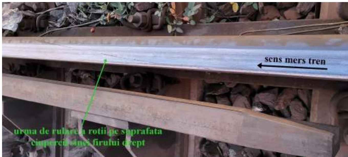
Figura nr.2 - Prima urmă de circulație deraiată
