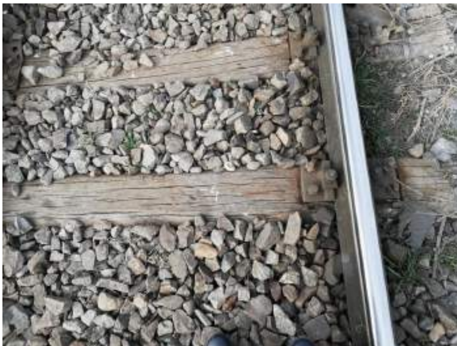
Foto. nr.4 – Prinderea șinei de traverse la traversele nr.-3, și nr.-4, pe firul exterior al curbei
