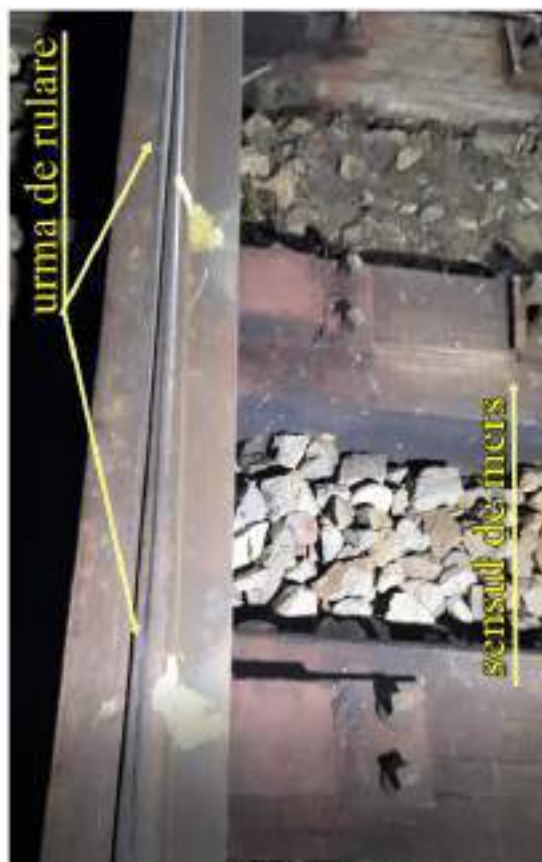
Foto. nr.15 – urma de rulare pe suprafața de rulare a acului curb al schimbătorului nr.21a
