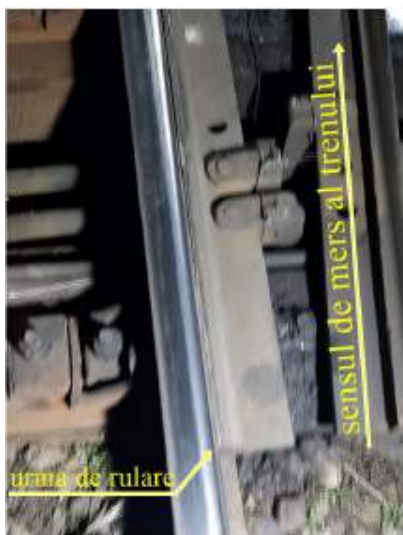
Foto. nr.12 – uzuri și știrbituri ale acului curb al schimbătorului nr.27a
