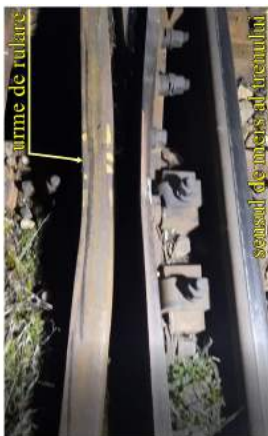
Foto. nr.14 – urma de rulare pe suprafața de rulare a inimii duble și pe a șinei cot
