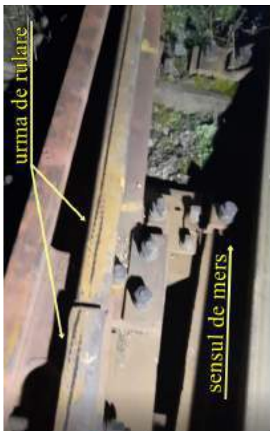
Foto. nr.15 – urma de rulare pe suprafața de rulare a acului curb al schimbătorului nr.21a
