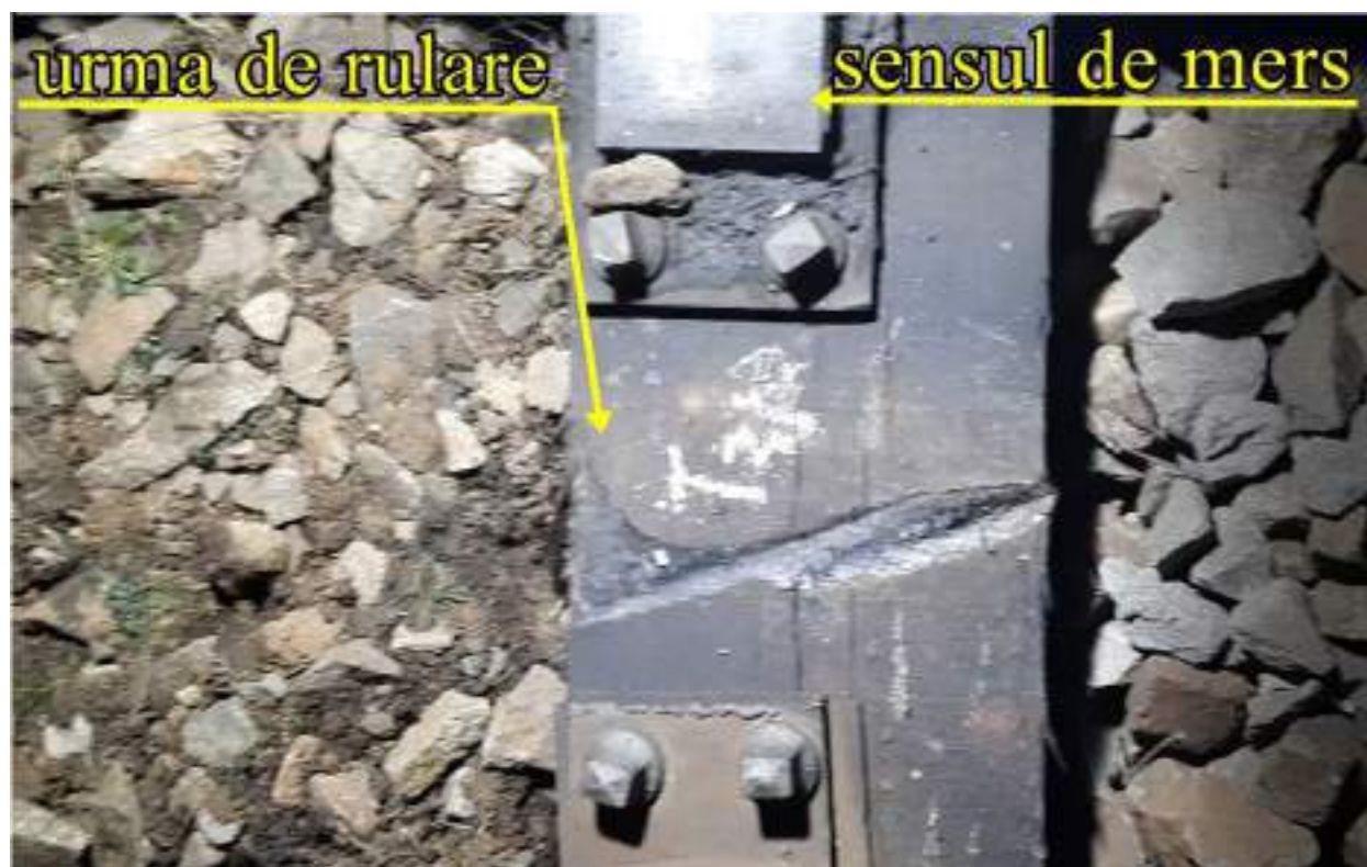
Foto. nr.29– urma de rulare pe traversele schimbătorului nr.21b
