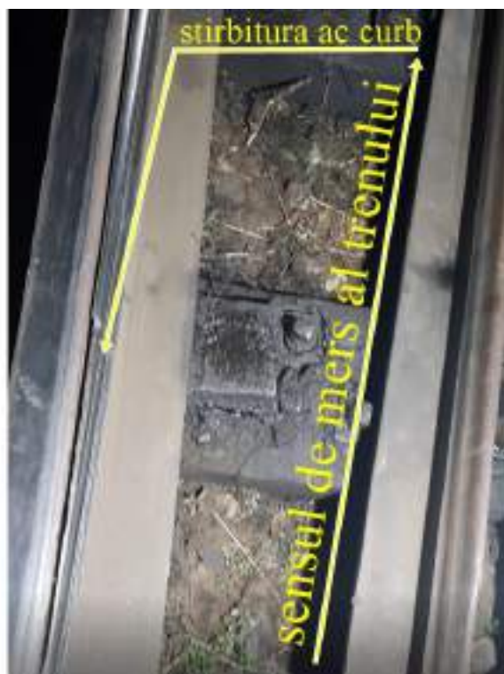
Foto. nr.12 – uzuri și știrbituri ale acului curb al schimbătorului nr.27a
