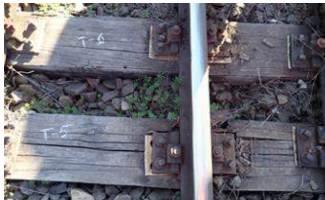
Foto nr.9 - traversele T 5 și T 6
