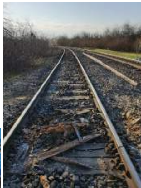
Foto nr.6, traverse rupte de vagoane pe zona deraiată
