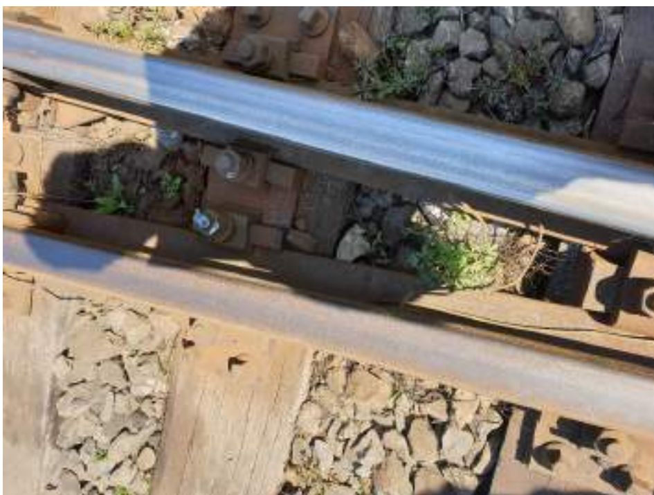
Foto nr.9 - Locul unde boghiul nr.2 al vagonului nr.33537965097-1 a lovit primul bulon
