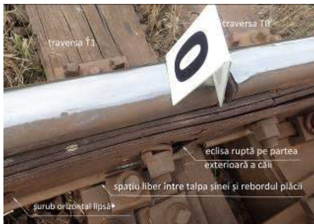
Foto nr.10 – eclisa ruptă în exteriorul căii
