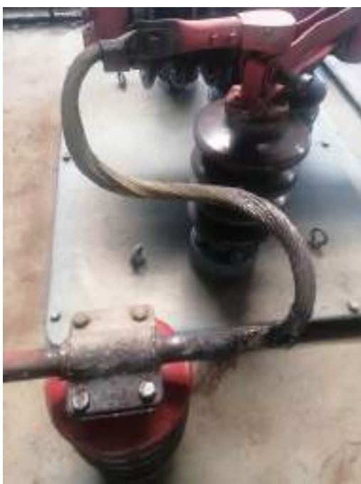
Foto nr. 1 - urme de arc electric de pe capătul barei de tensiune, legătura flexibilă, clema și șuruburile de strângere a barei de tensiune
