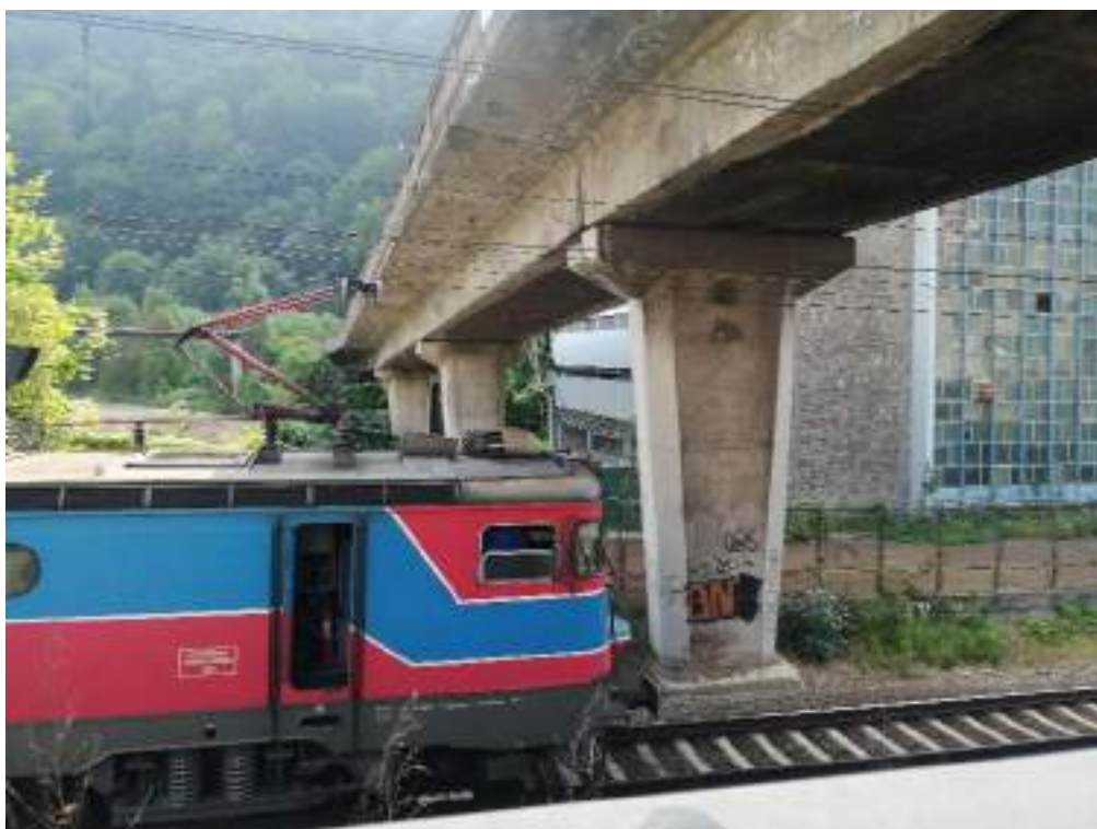
Foto nr. 8 - pasarela dezafectată situată între stațiile Sinaia și Bușteni la km 131+800
