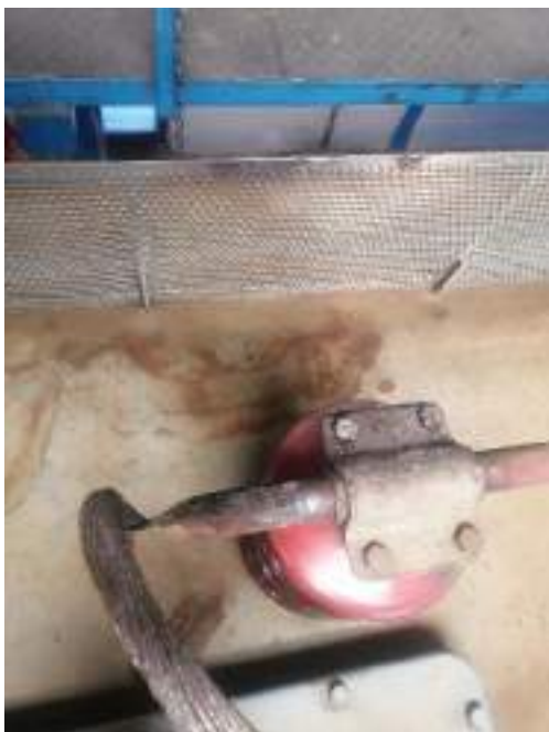
Foto nr. 2 - urme de arc electric pe grilajul de protecție din dreptul disjuncteurului
