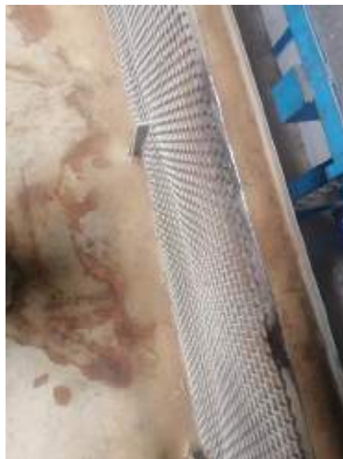
Foto nr. 2 - urme de arc electric pe grilajul de protecție din dreptul disjuncteurului
