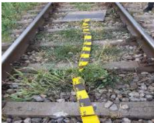
FOTO nr. 4, traversa lovită, în cădere, de către capacul obturator; capac obturator găsit poziționat la 2,70m de lovitură traversei
