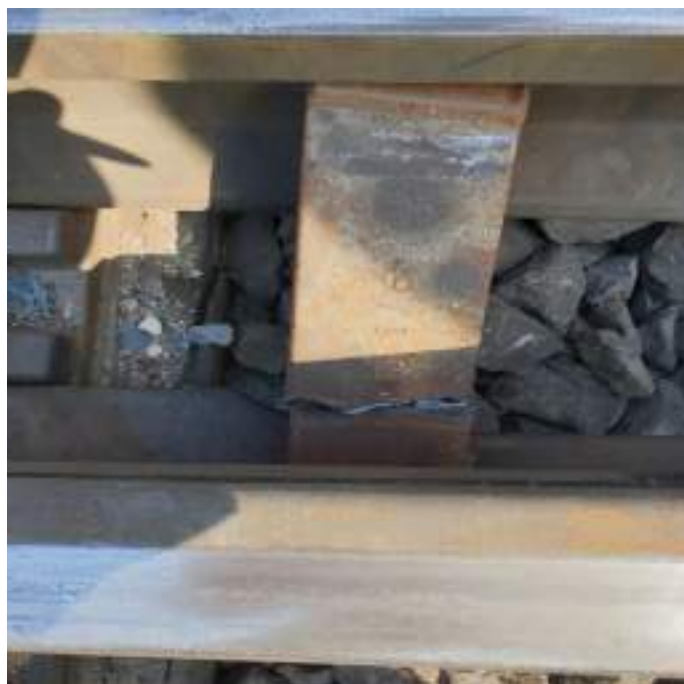
Foto nr.5 - proțap al macazului nr.17 rupt
