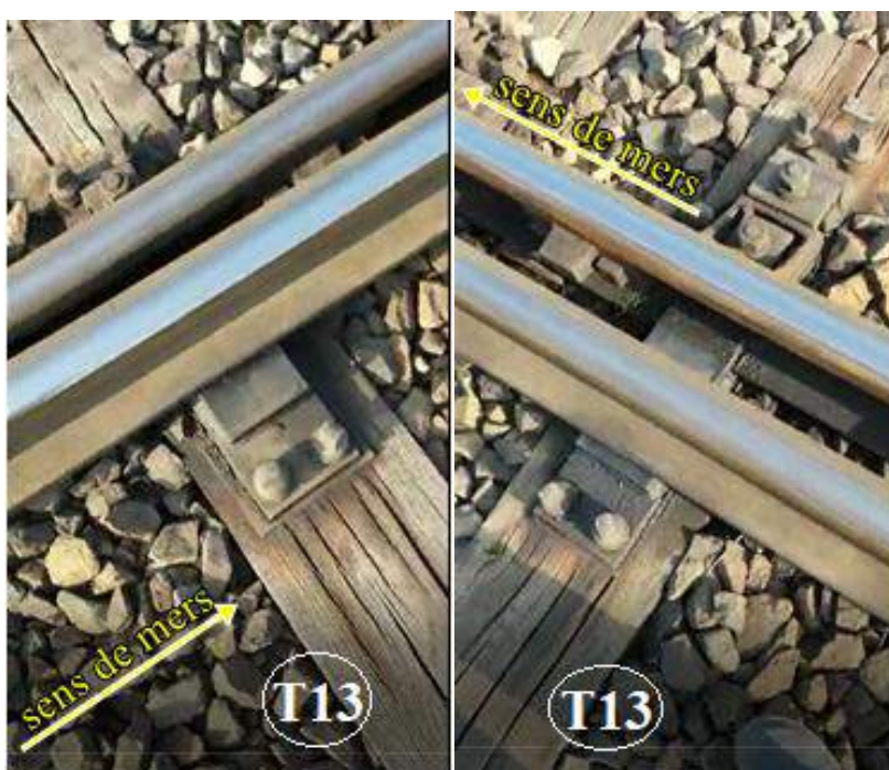
Foto nr.10 - traversa T13 - prinderea placă-traversă pe partea stângă și pe partea dreaptă
