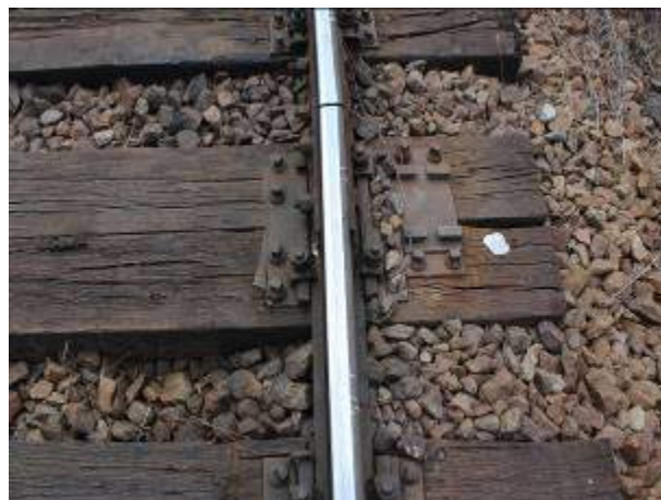
Foto nr.4 - joanta de pe firul exterior al curbei
