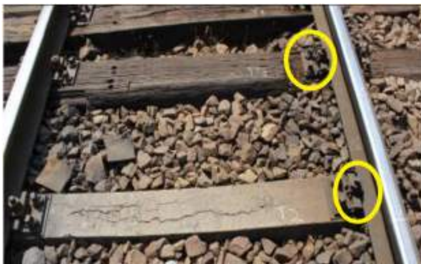
Foto nr.5 – starea prinderilor SKL în zona punctului „0” (la traversa T 2 , T 3 )
