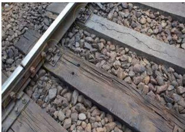
Foto nr.3- joanta de pe firul interior al curbei
