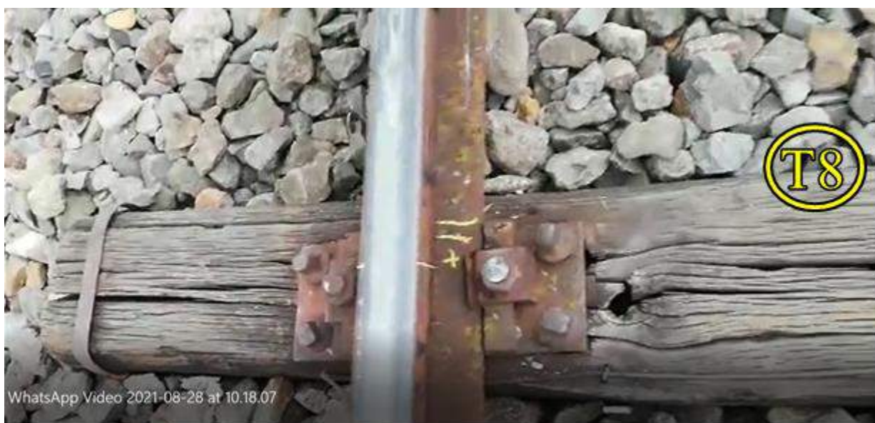
Foto. nr.18 – Prinderea șinei de traverse la traversa T8, pe firul interior al curbei
