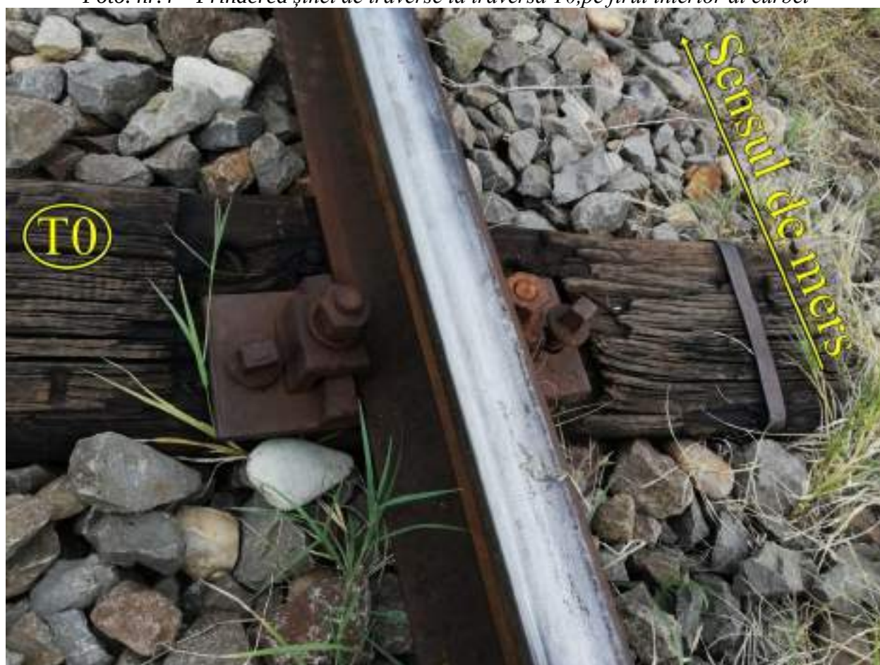
Foto. nr.4 – Prinderea șinei de traverse la traversa T0,pe firul interior al curbei
