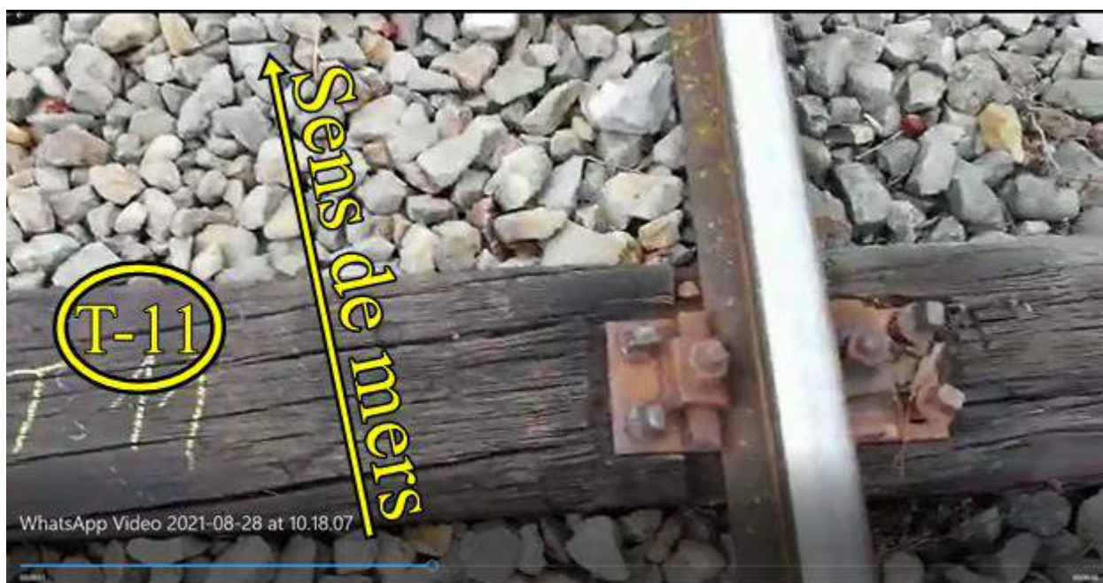
Foto. nr.11 – Prinderea șinei de traverse la traversa T-11, pe firul exterior al curbei
