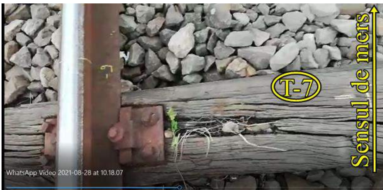
Foto. nr.9– Prinderea șinei de traverse la traversa T-7,pe firul exterior al curbei
