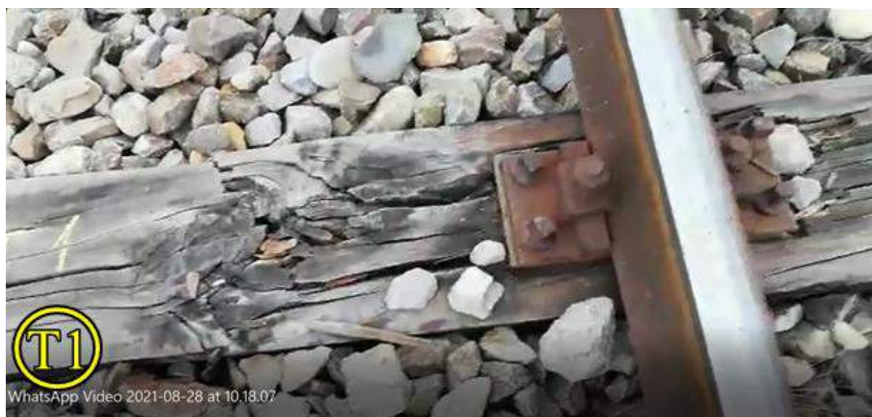
Foto. nr.13– Prinderea șinei de traverse la traversa T1,pe firul exterior al curbei
