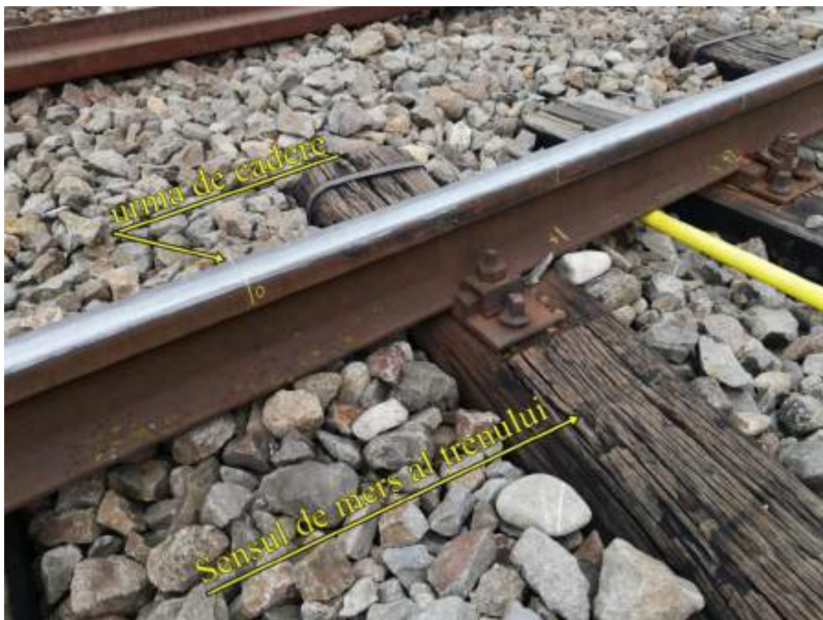
Foto nr.3 - urma de cădere a roții între firele căii
