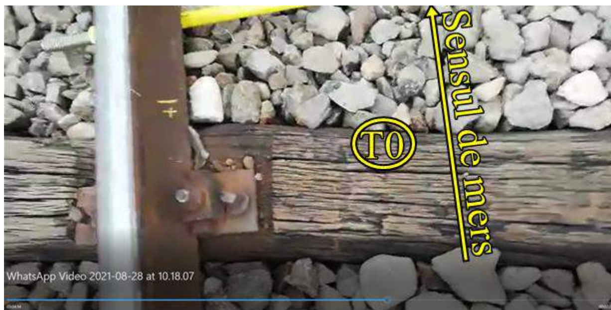
Foto. nr.4 – Prinderea șinei de traverse la traversa T0,pe firul interior al curbei
