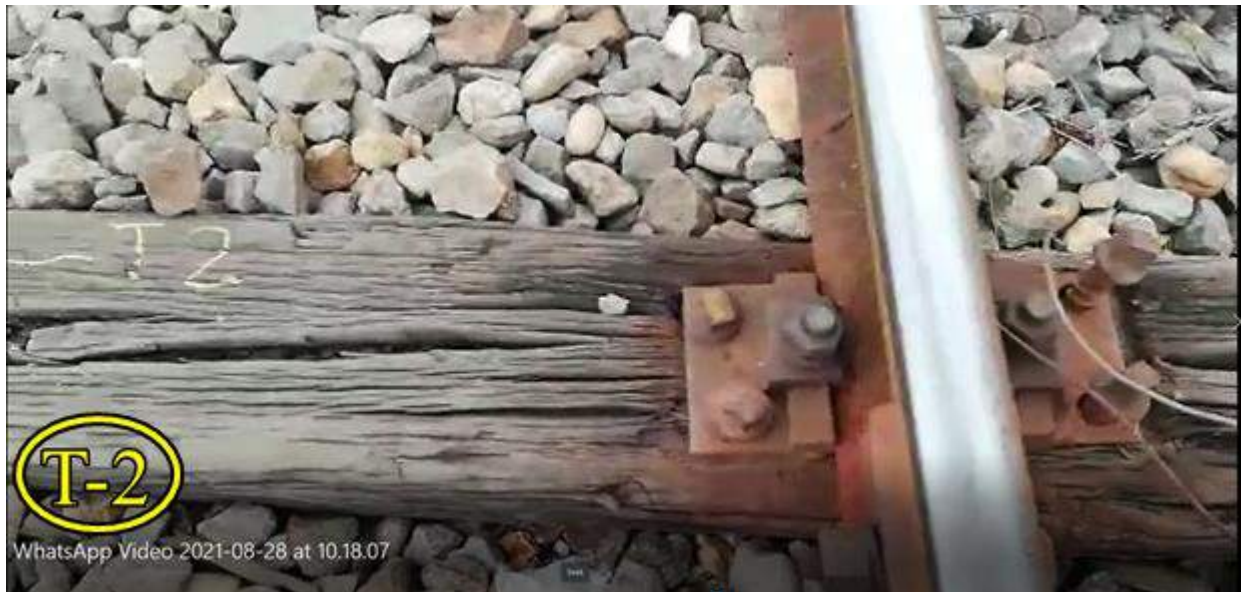
Foto. nr.6 – Prinderea șinei de traverse la traversa T-2,pe firul exterior al curbei
