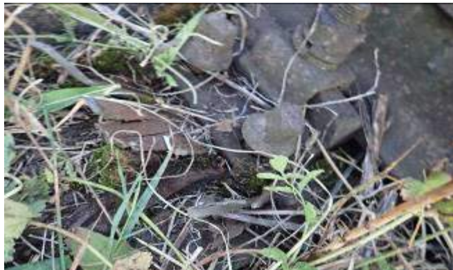
Foto nr.14 - traversa „T-2”(zona de capăt)
