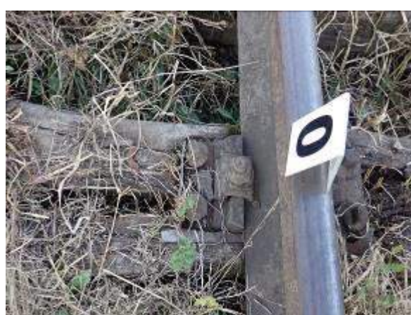
Foto nr.9- traversa „T-1” (exteriorul căii)
