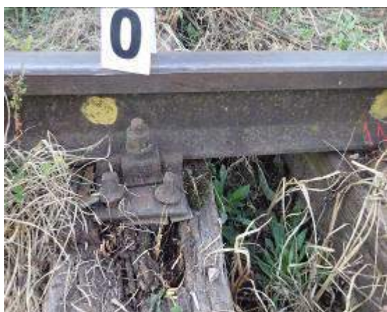
Foto nr.8 - traversa „T-1”(interiorul căii)
