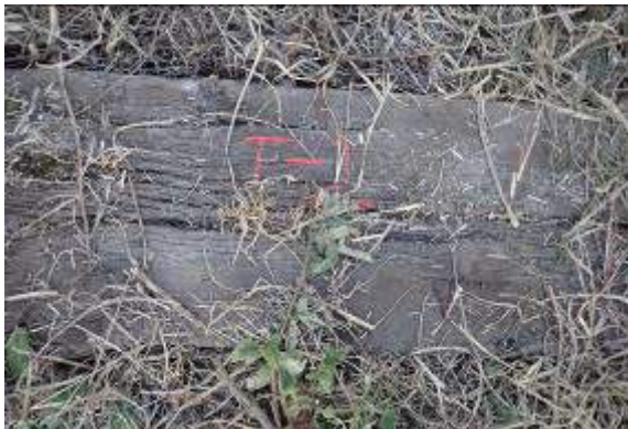
Foto nr.13- traversa „T-2”(zona centrală)
