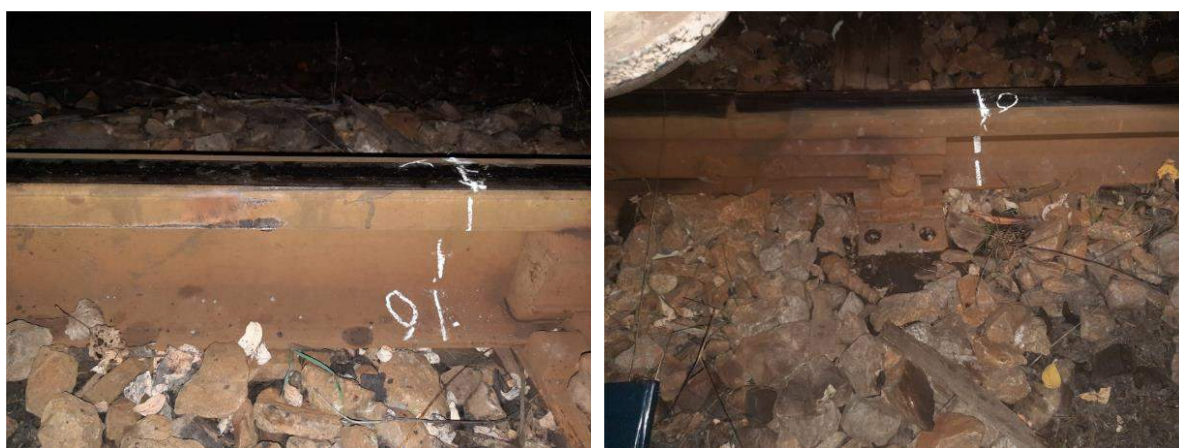
Foto nr.2: Prima urmă de deraiere la km. 25+333 punct "0" (fir stâng /fir drept).
