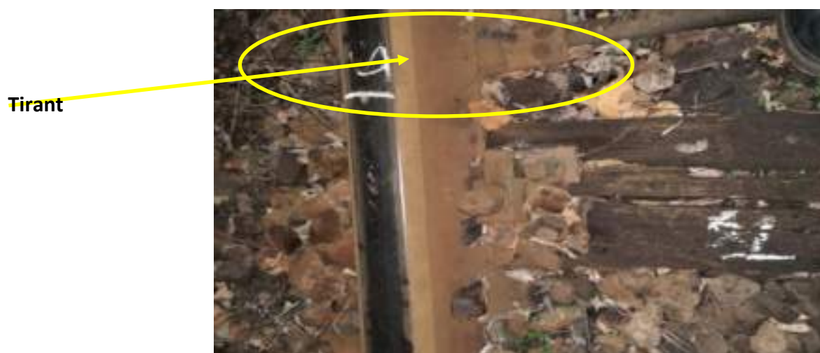
Foto nr.5: Dispozitiv improvizat pentru menținerea ecartamentului(tirant).
