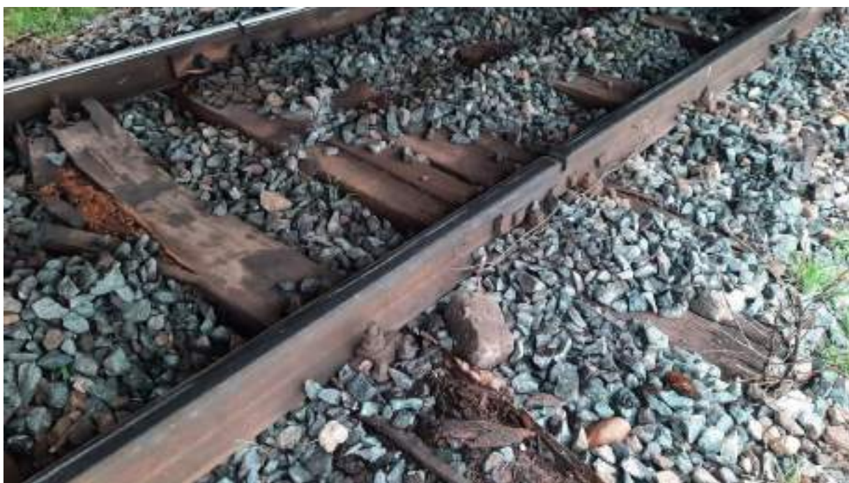
Foto nr.4: urmă de rulare a buzei bandajului pe suprafața de rulare a șinei din dreapta
