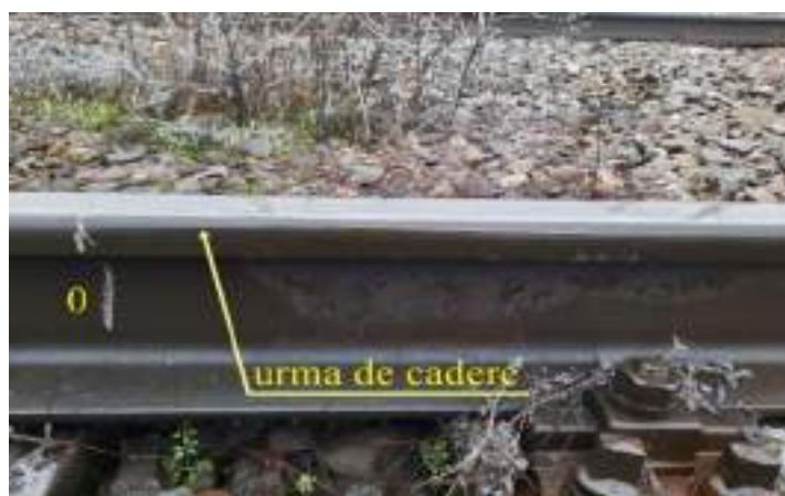
Foto. nr.10 – zona punctului „0”
