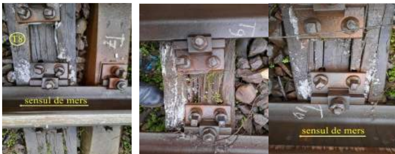
Foto. nr.9 - Traversele T8, T9 și T10
