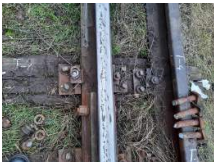
Foto nr.6 - Joanta mecanică situată la 1380 mm după punctul „0”
