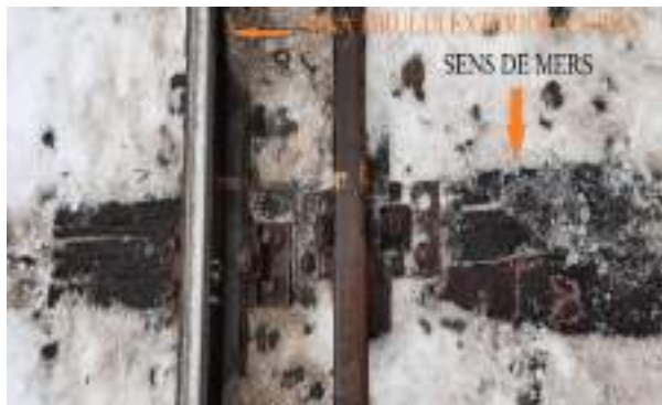
Imaginea 16 – traversa „T 8 ”(pct.de măsurare,,10”)
