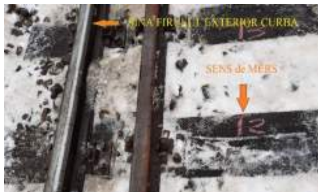
Imaginea 13 – traversa „T 2 ” zona spre fir exterior
