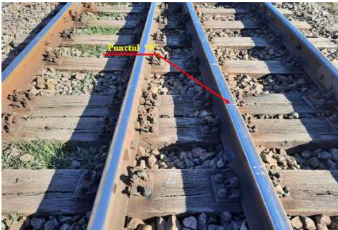
Foto. nr.12– Punctul „0”: prima urmă de rulare a buzei bandajului unei roți
