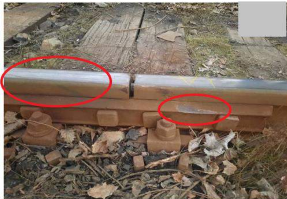
Foto nr.2: Urmă de cădere în exteriorul căii după punctul "A"
