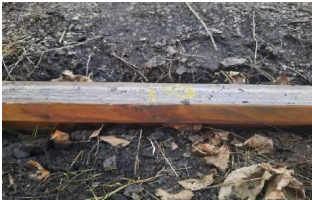
Foto nr.1: Prima urmă de deraiere la km. 40+283 punct "0" (firul din stânga).
