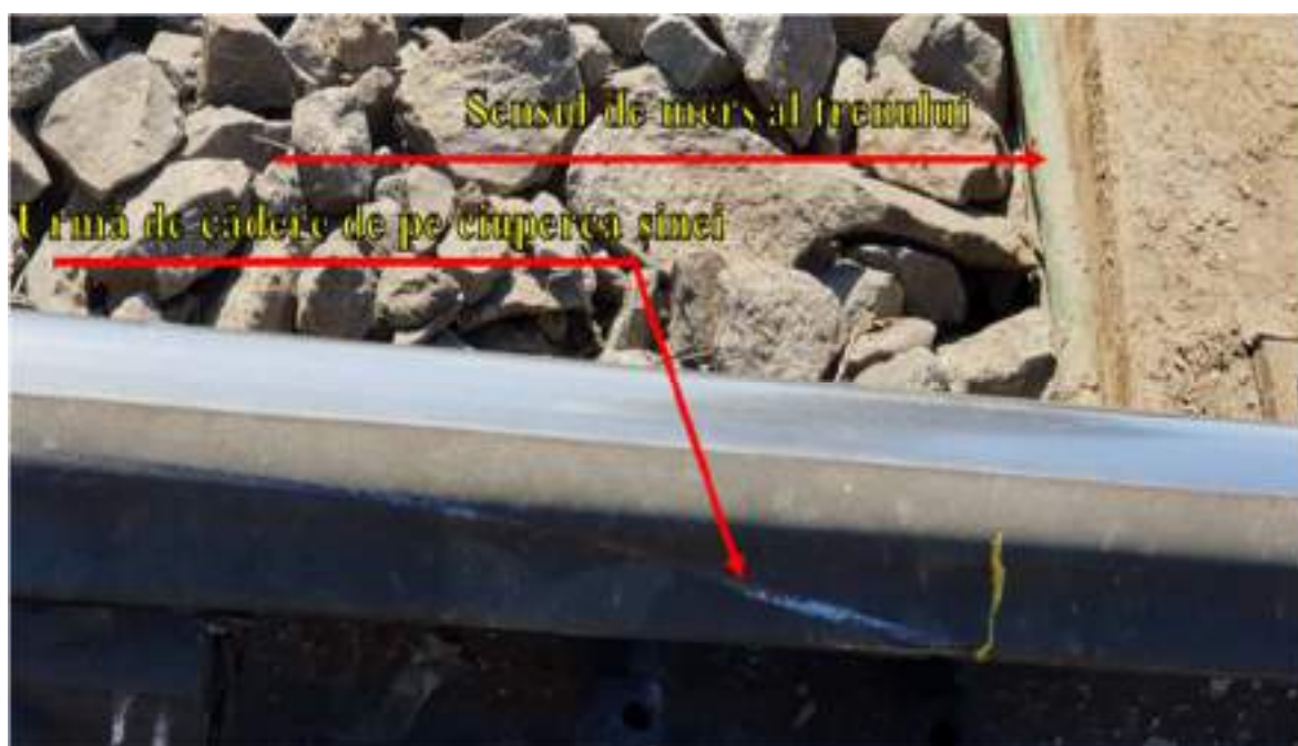
Foto nr. 4: Urma de cădere de pe ciuperca șinei firului exterior al curbei
