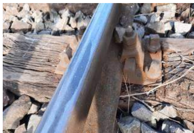
Foto.nr.6 - traversa T 4 (după manevrarea plăcilor metalice și redeschiderea circulației)
