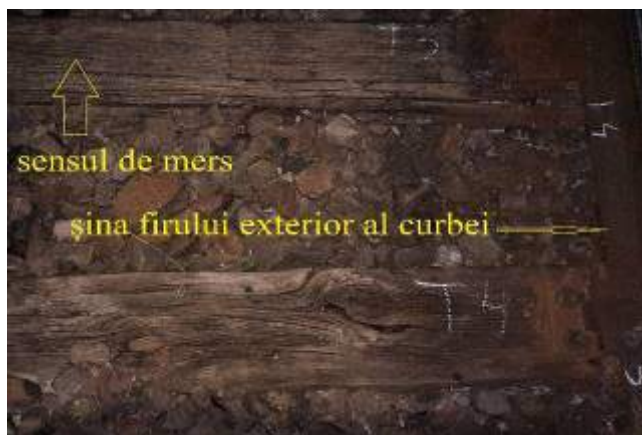
Foto.nr.5 - traversa T 4
