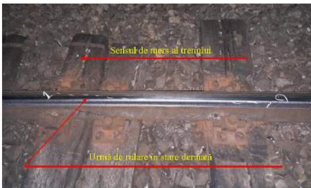
Foto nr.1 -Urmă de rulare pe ciuperca șinei firului exterior al curbei
