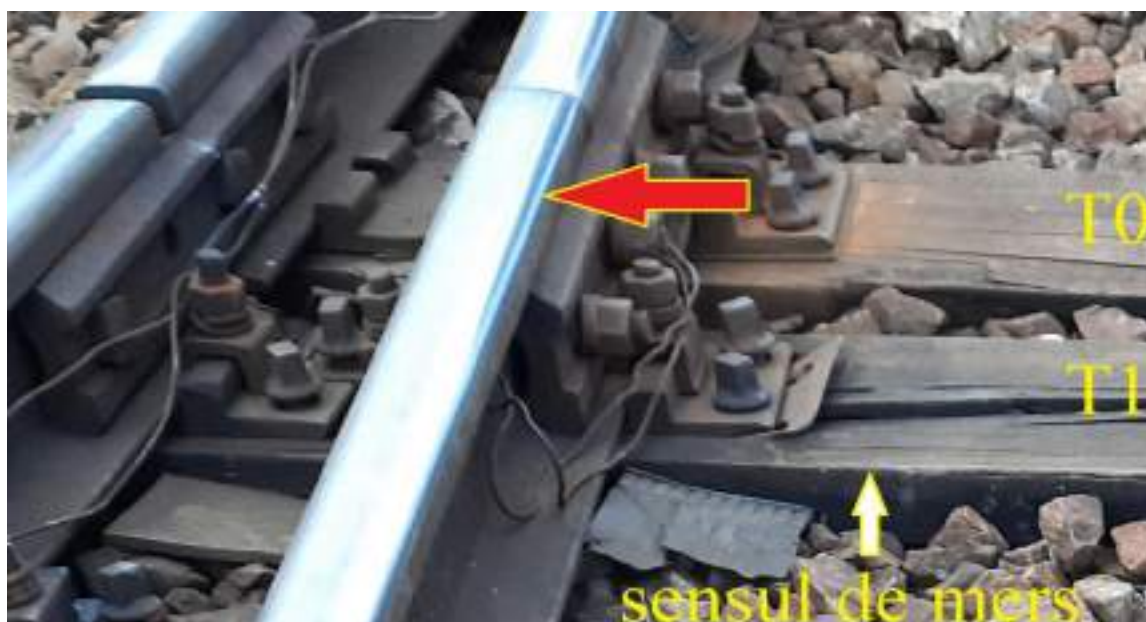
Imaginea nr.10 – joanta de capăt pe abaterea schimbătorului (partea stângă în sensul de mers)
