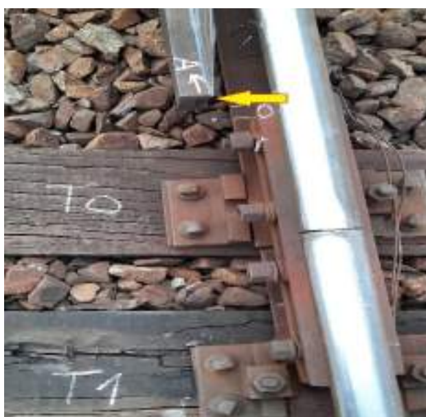
Imaginea nr. 7 - urma de lovire și escaladare a roților din dreapta pe capătul contrașinei – punctul A
