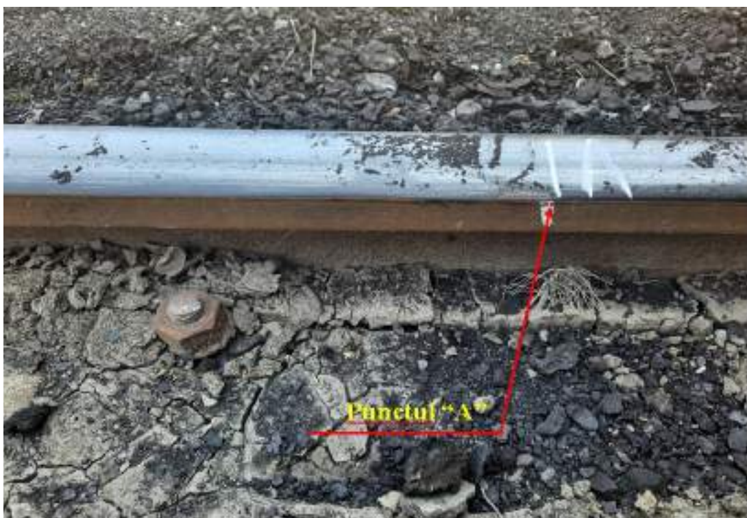
Foto nr.4, punctul „A”: urmă de cădere de pe suprafața de rulare a șinei în interiorul căii
