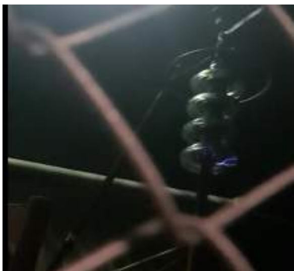
Foto nr. 13 - apariția descărcărilor electrice locale
