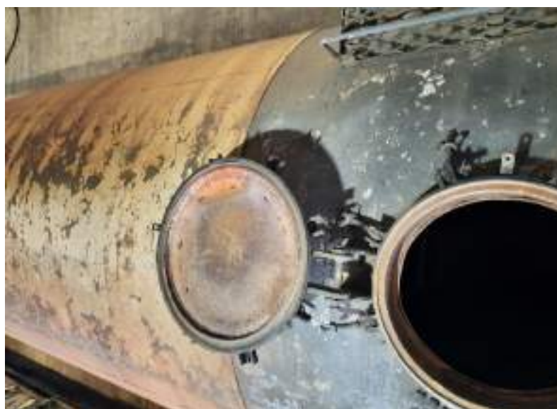
Foto nr. 8 – ușoare urme de afectare termică la partea exterioară pe partea dreaptă
