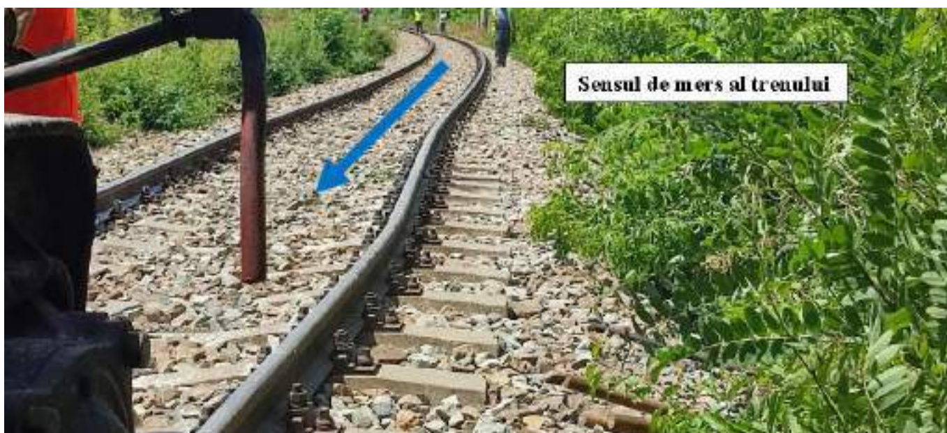
Foto nr.15, deriparea văzută din sensul invers de mers al trenului și al kilometrajului
