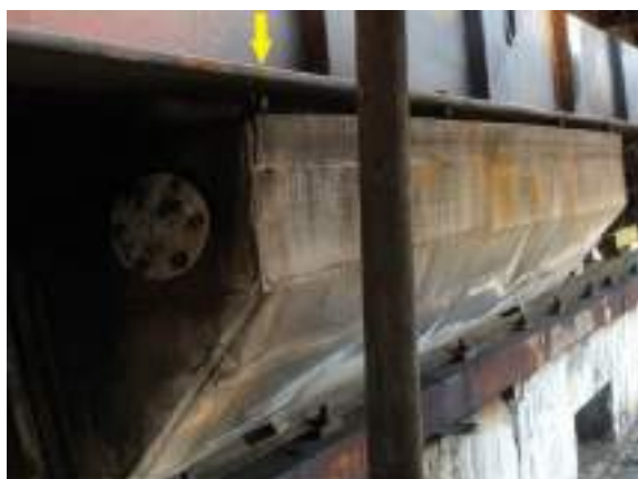
Imaginea nr.11 – partea din față a rezervorului era deplasată în jos cu 2,5 cm Filetul smuls al șurubului prezenta urme de rupere nouă, fără urme de rugină.
