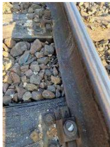
Foto nr.2, urmele de escaladare și cădere a primei osii a locomotivei
