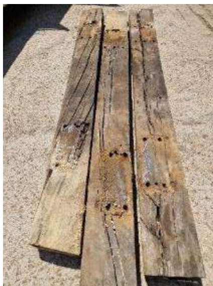
Foto nr.4, T2, 3 și 4 traverse putrede
