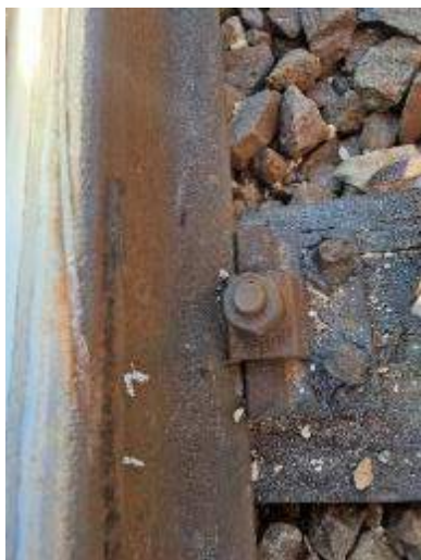
Foto nr.2, urmele de escaladare și cădere a primei osii a locomotivei
