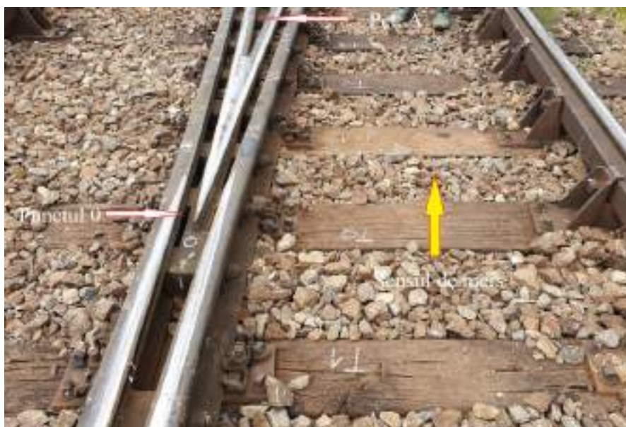
Imaginea nr.6: Traversele în zona punctului de deraiere
