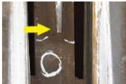
Imaginea nr.5: urma de lovire de către roata din partea stângă a vârfului inimii de încrucișare – punctul 0
