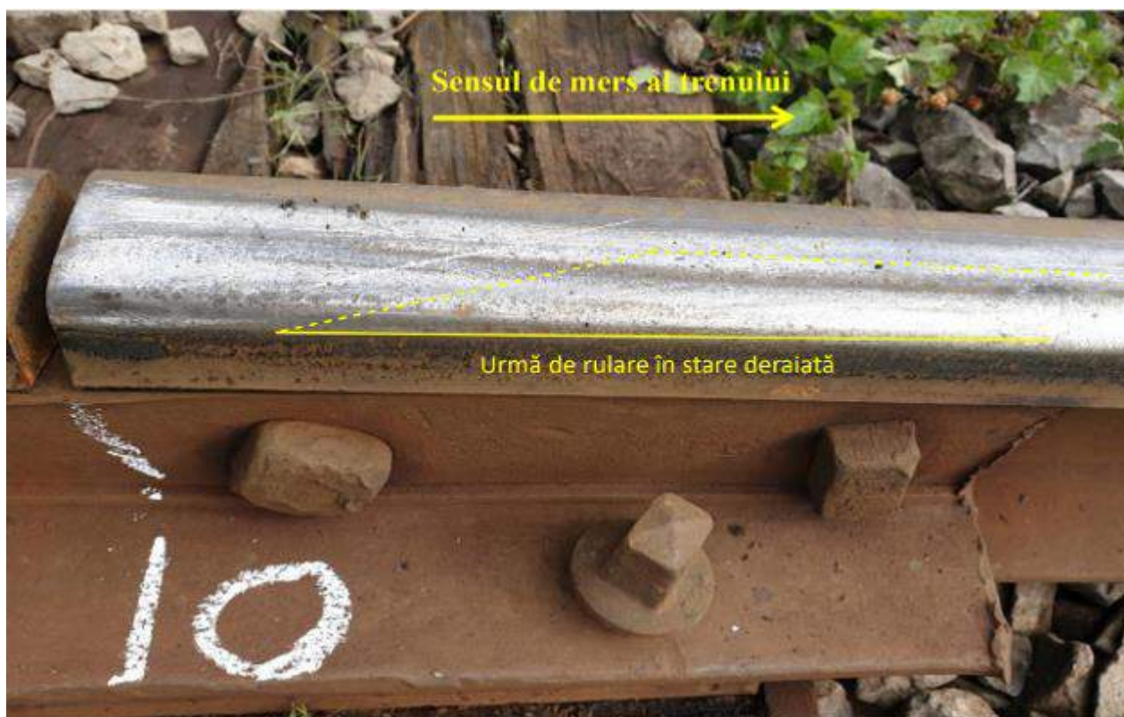
Foto nr.1 -Urma de rulare pe ciuperca șinei firului exterior al curbei
