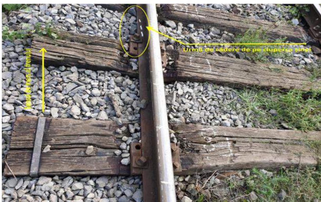
Foto nr.4 - Urma de cădere de pe ciuperca șinei firului exterior al curbei
