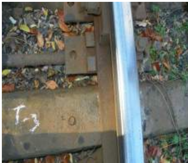
Foto.nr.11 - Traversa T 3
