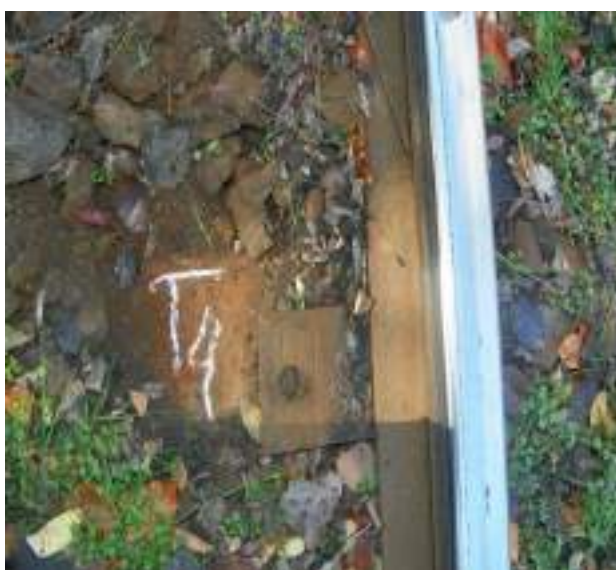
Foto.nr.15 - Traversa T 4
