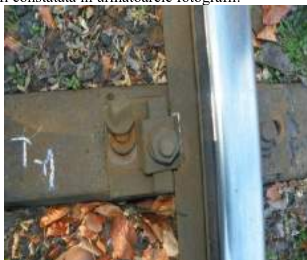
Foto.nr.9 - Traversa T -1
