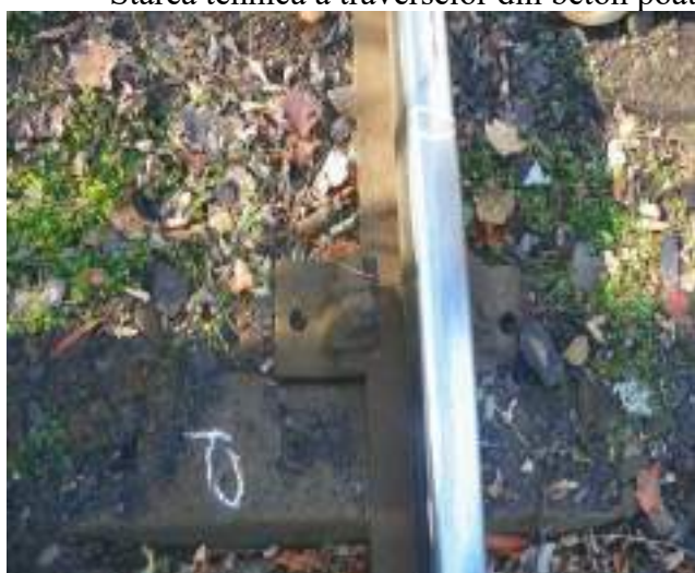
Foto.nr.8 - Traversa T 0
