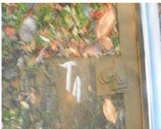
Foto.nr.12 - Traversa T 1
