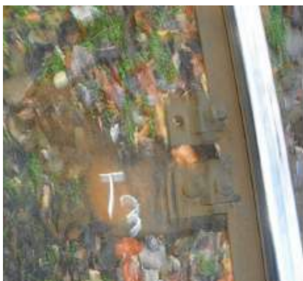
Foto.nr.14 - Traversa T 3
