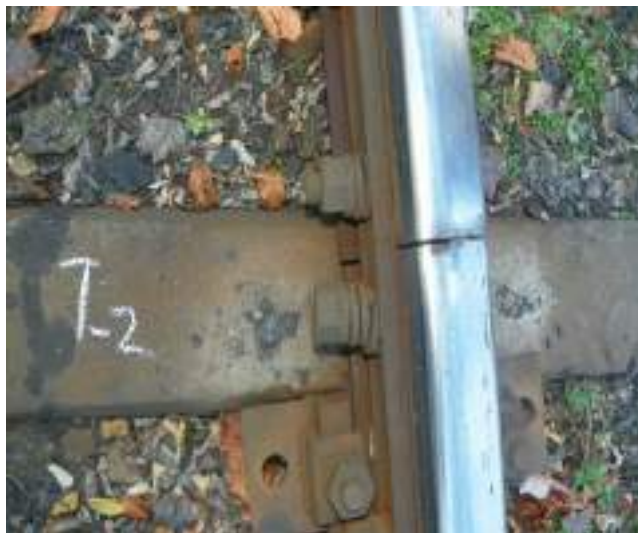
Foto.nr.10 - Traversa T 2
