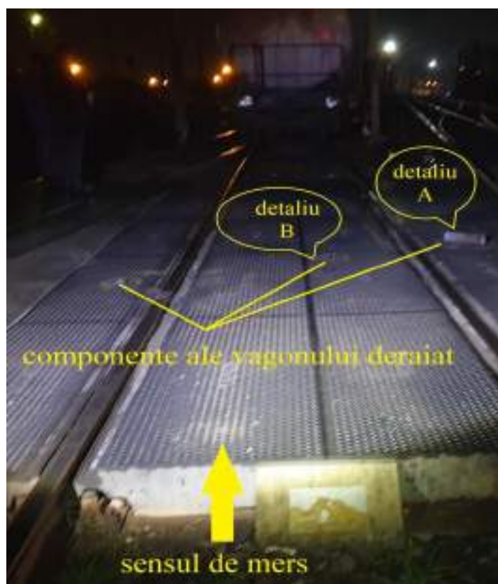
Imaginea nr.5 : componente ale vagonului deraiat
