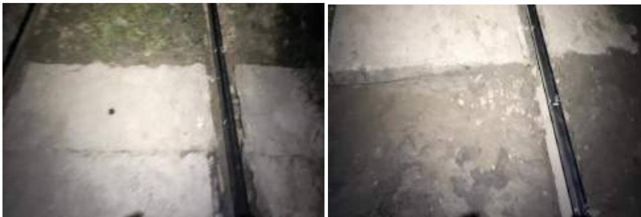
Imaginea nr. 12 – prisma de piatră spartă în zona trecerii la nivel cu calea ferată km 98+564
