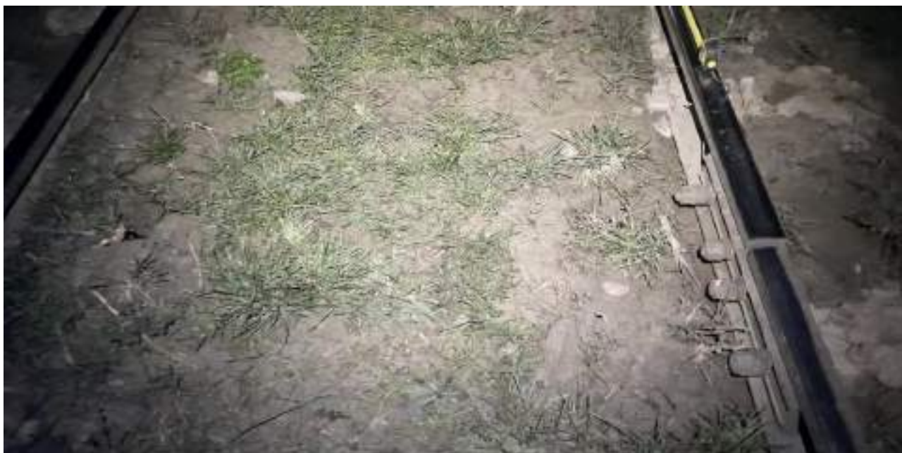
Imaginea nr. 13 – prisma de piatră spartă în zona joantei de pe firul exterior al curbei
