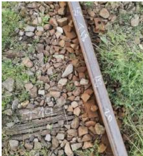
Foto. nr.8 – Starea tehnică a traverselor T 19 și T 18
