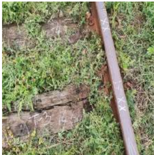
Foto. nr.12 – Starea tehnică a traverselor T 3 și T 4
