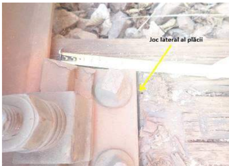
foto nr.11- Joc lateral al plăcii de prindere a șinei
