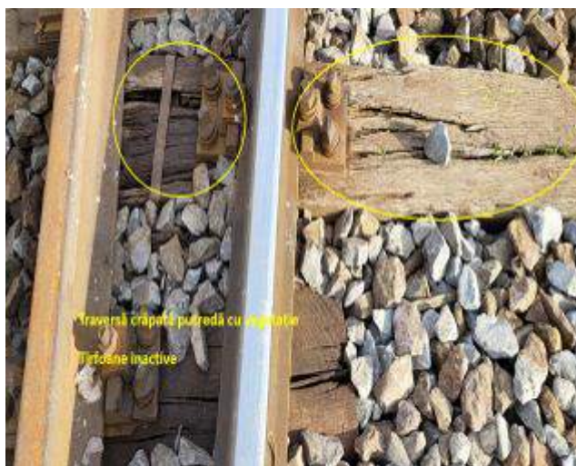
Foto.nr.16 – Traversa T-35
