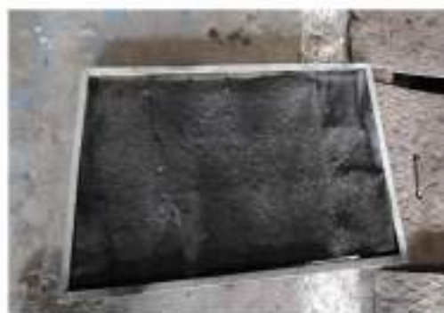
Imaginea nr.3 – starea tehnică a bateriei de încălzire/climatizare
