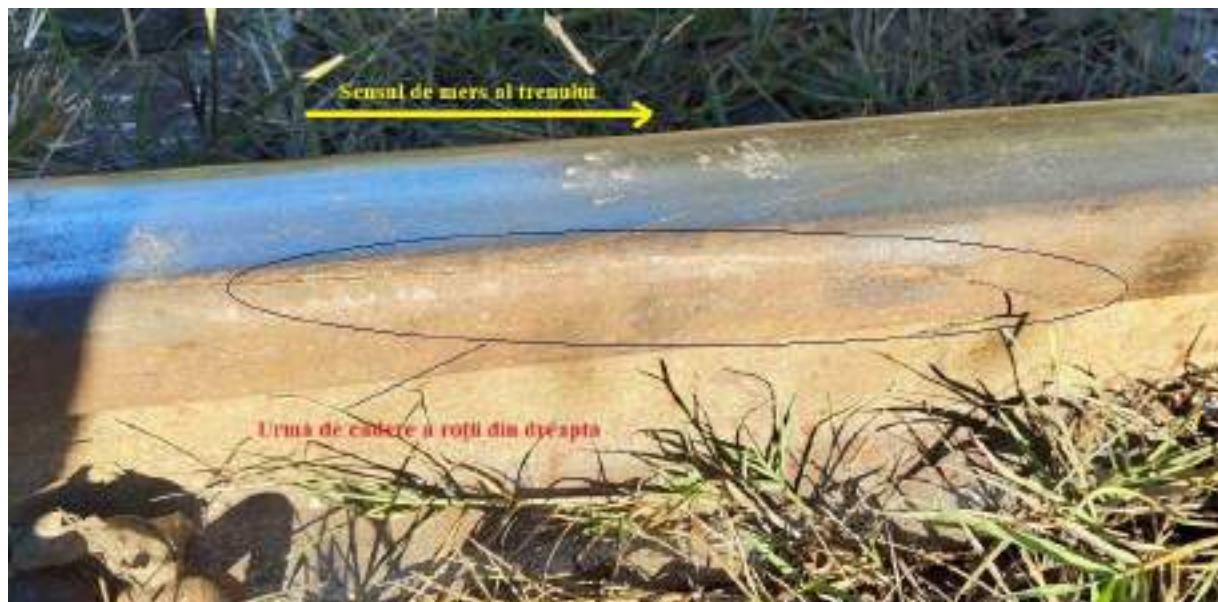
Foto. nr.15 – Urmă de cădere a roții din partea dreaptă
