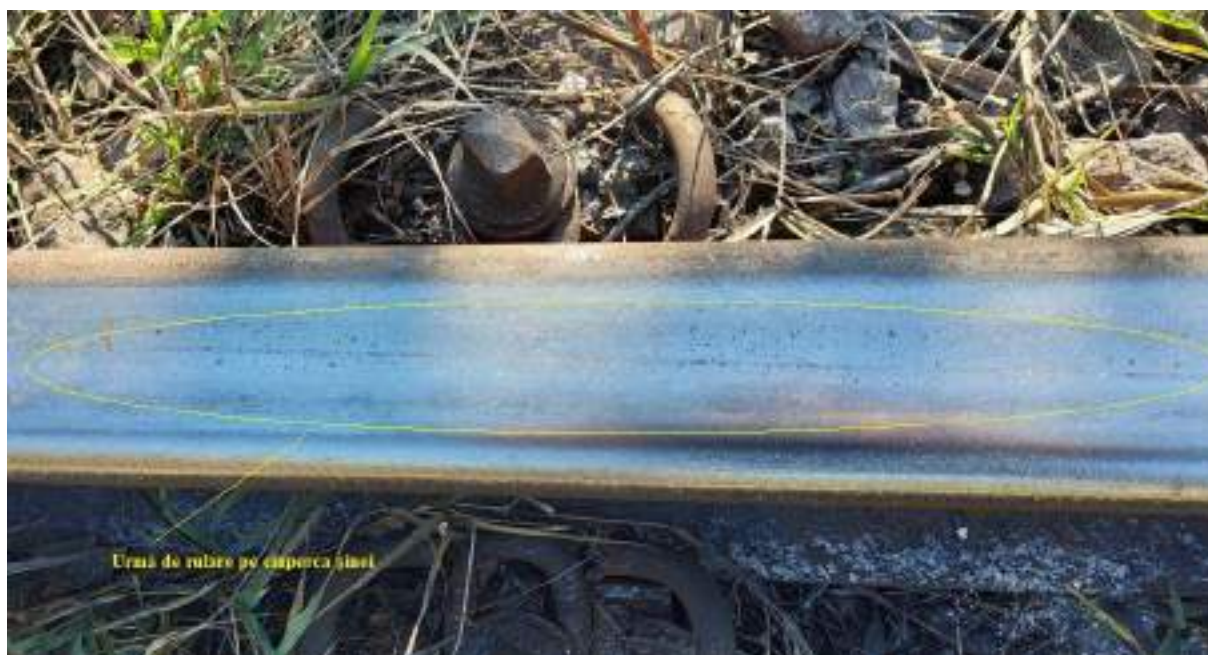
Foto. nr.14 – Urmă de rulare a buzei bandajului roții pe ciuperca șinei
