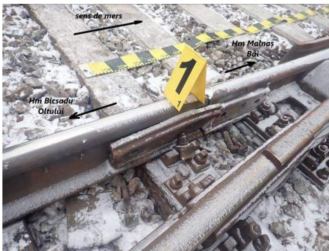
Foto nr.5 – Joanta capăt schimbător nr.1R cu eclisa metalică exterioară
