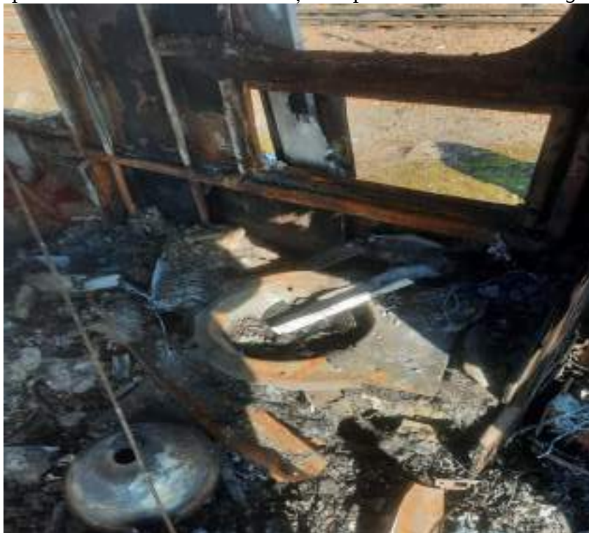
Imaginea nr.7 - zona perete cabina WC / perete salon
