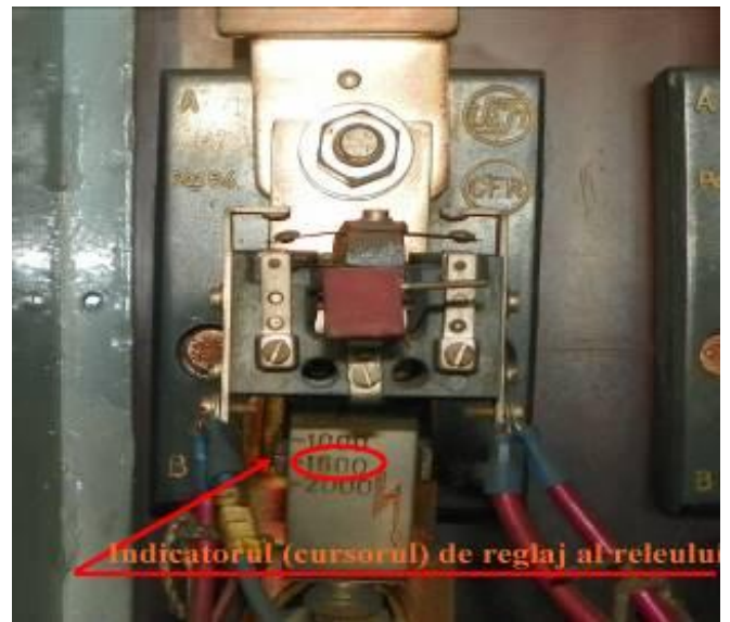
Fig.6 Cutia releelor de curent maximal grupe MET Fig.7 Releu maximal de curent poziția 54, grupa 1-4 MET
