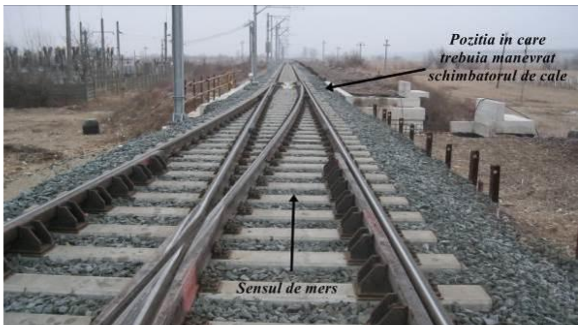
Foto nr.2 – Poziția în care trebuia să fie manevrat schimbătorul de cale nr.15
