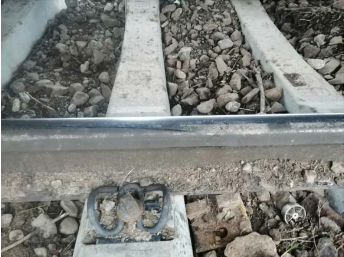
Foto nr. 2 - Urmă de rulare a roții din dreapta care a circulat cu buza bandajului pe suprafața de rulare a șinei.
