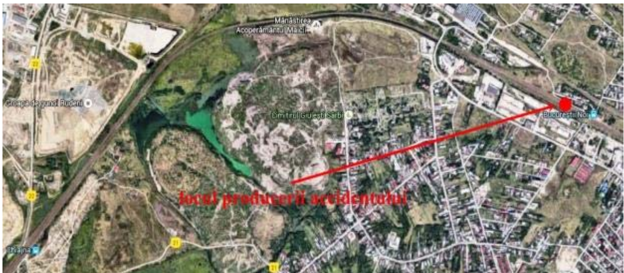
Figura. nr.1. Locul producerii accidentului feroviar
