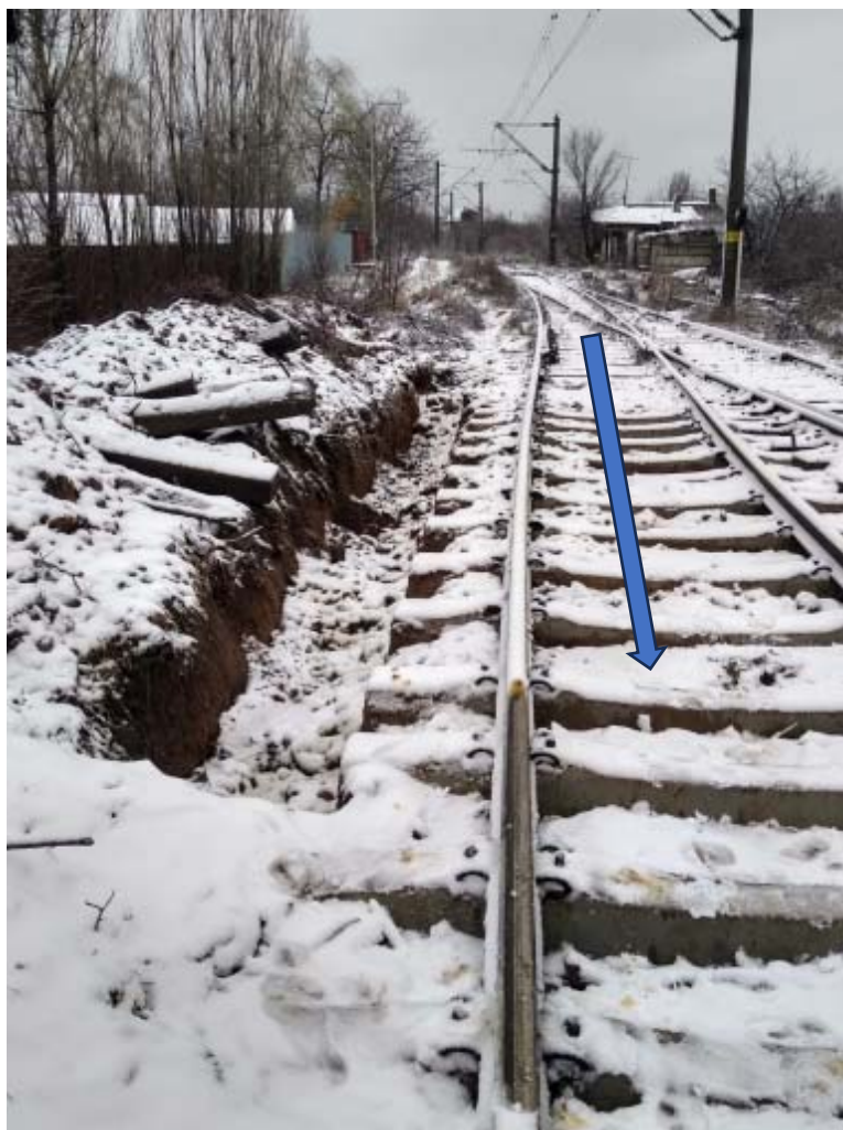
Foto nr.3 –șanțul aflat înainte de punctul 0.
