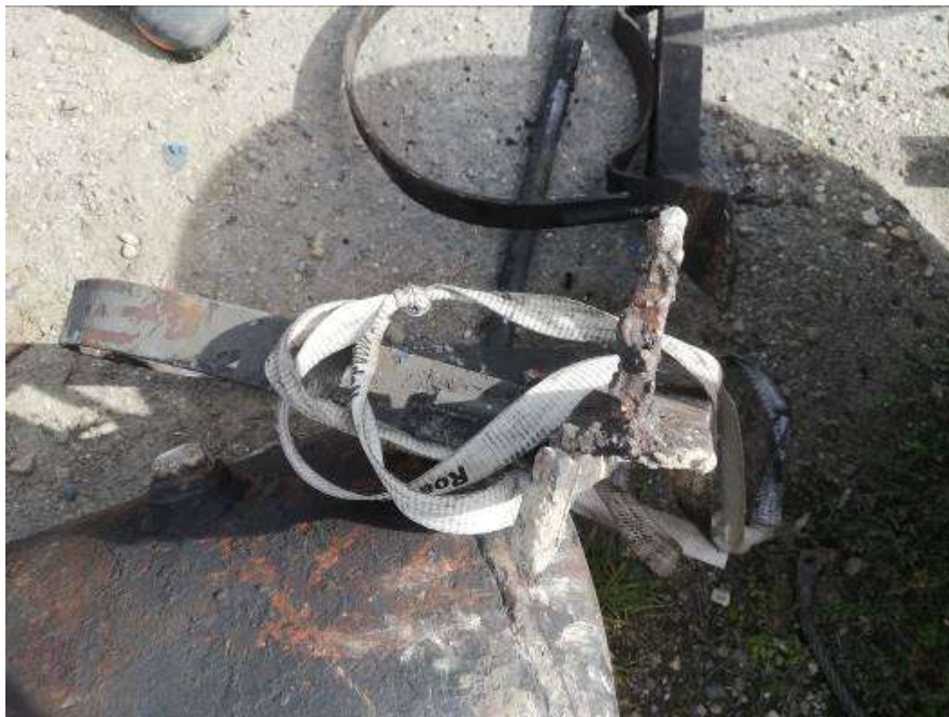
Foto nr.10- Brida de fixare a rezervorului de suporți
