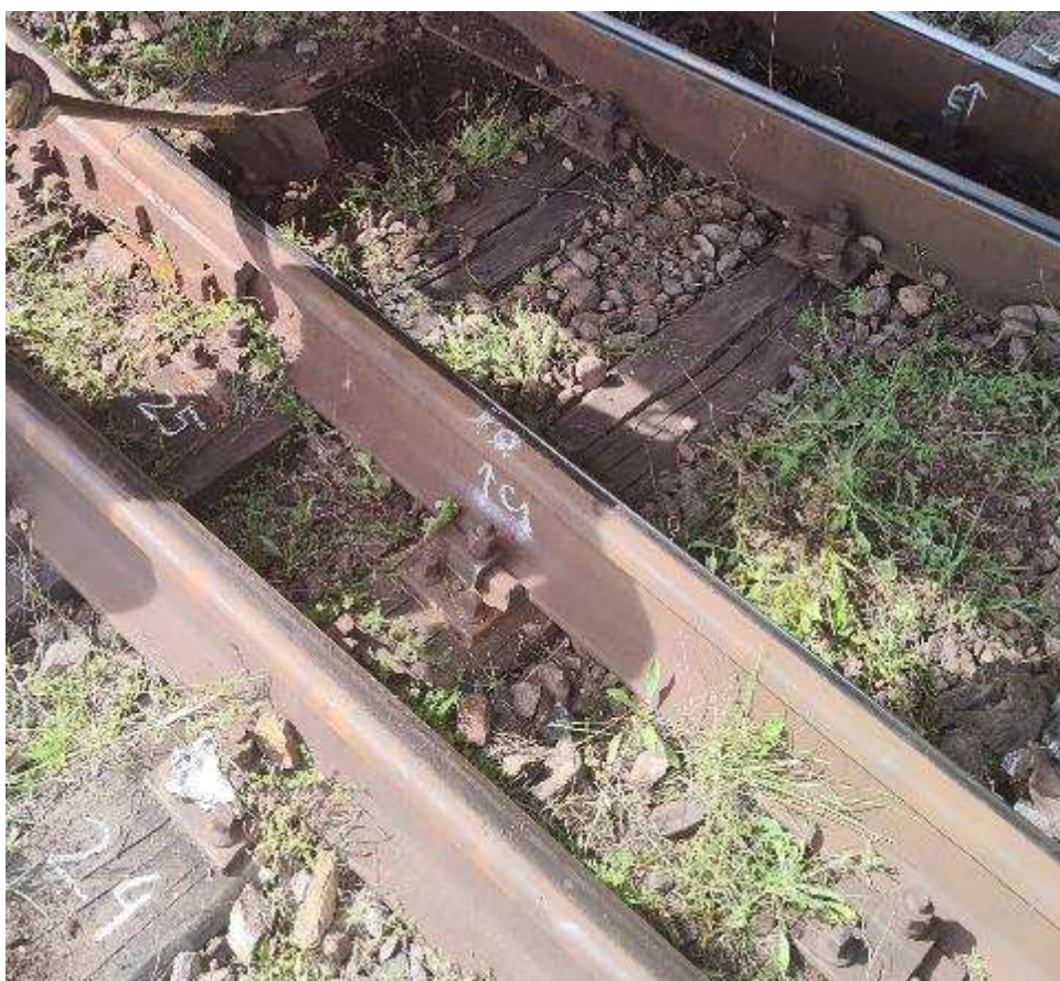
Foto nr.3 - Prima urmă de cădere - punctul „0”
