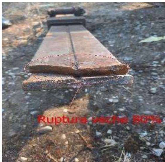
Foto nr.7 Ruptură veche 80%
