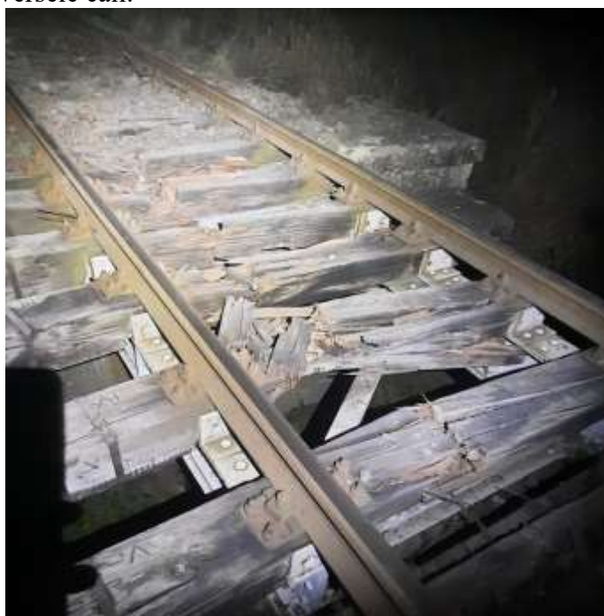
Foto nr. 7 – Traversele podețului feroviar de la km76+580
