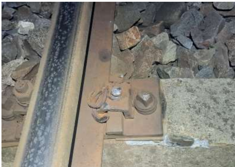
Foto nr. 6 – prima urmă de cădere pe firul din stânga la 5,5 metri de punctul „0”
