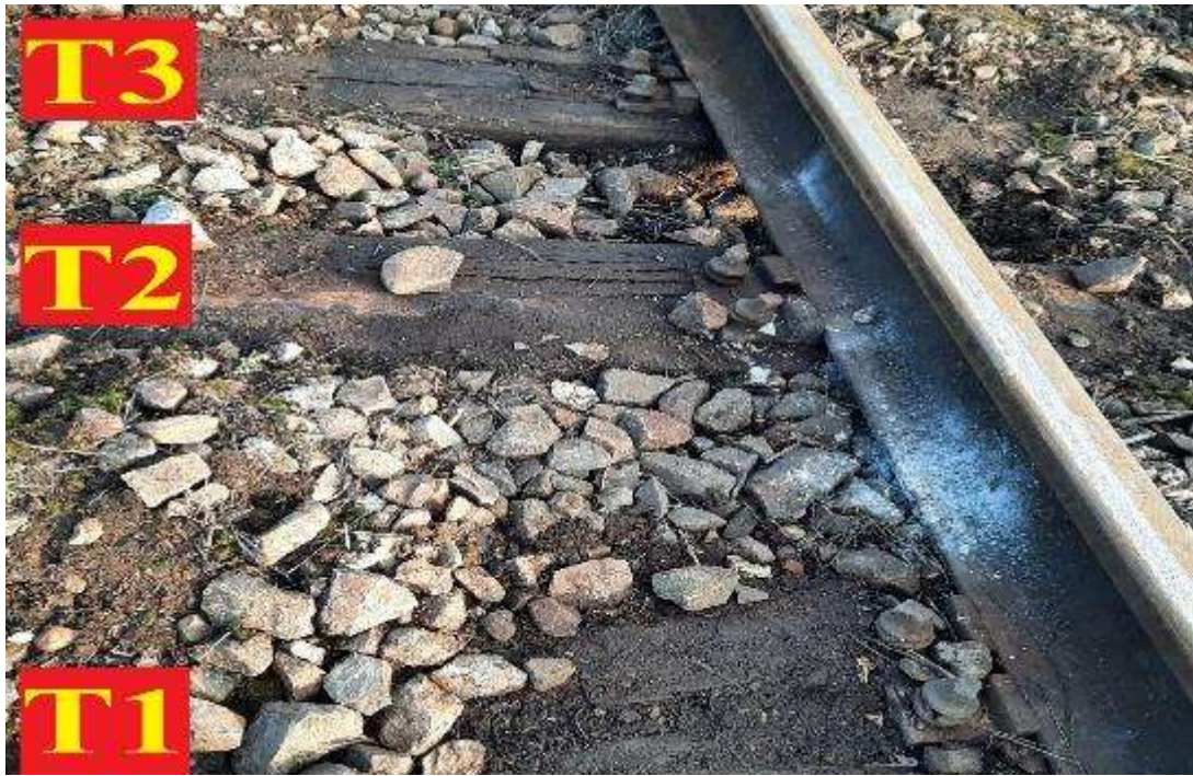
Imaginea nr.20 - traversele T1, T2 și T3 interiorul căii, șina firului exterior a curbei
