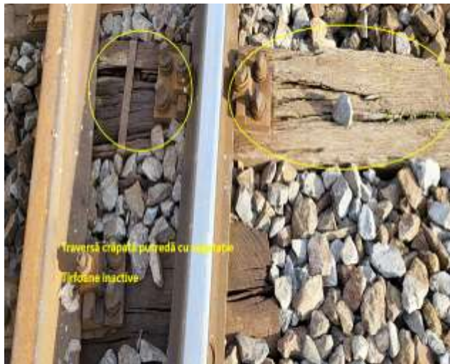
Foto.nr.16 – Traversa T-35
