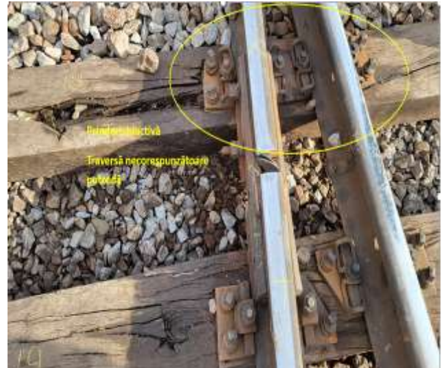
Foto.nr.11 – Traversa T-18
